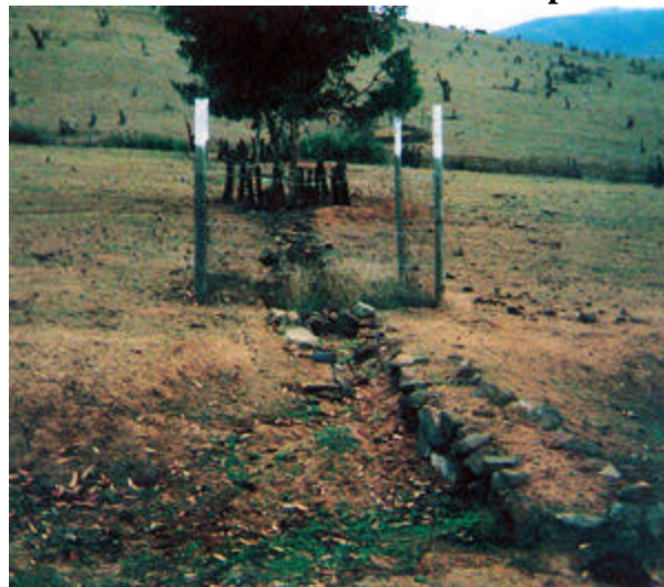
Figura 12 Canaleta de desviación con casilla de plantación
