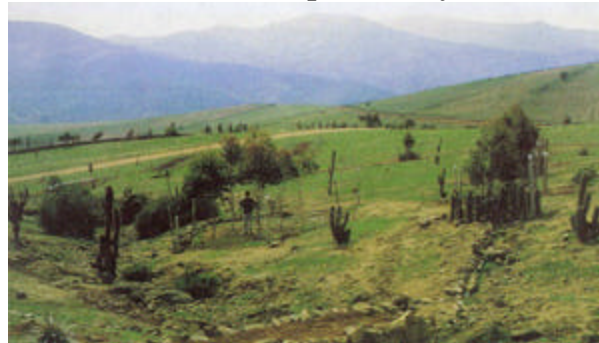
Figura 11 Dique hecho manualmente en la quebrada y canaleta de desviación
