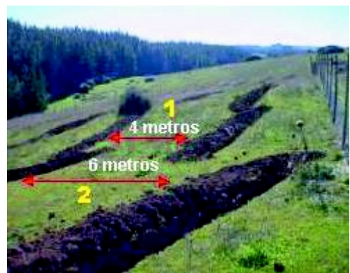
Fotografía 5. Distanciamiento de zanjas de infiltración en la ladera (Comuna de Litueche, VI Región)
