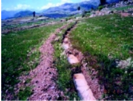
Fotografía 3. Zanjas de Infiltración con agua almacenada (Bolivia)
