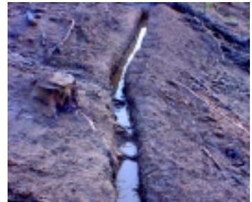
Fotografía c. Funcionamiento de la zanja de infiltración después de una lluvia
