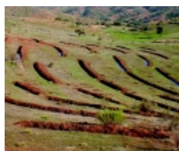
Fotografía c. Funcionamiento de las zanjas de infiltración
