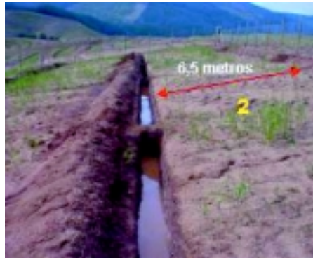
Fotografía 10. Distanciamiento de zanjas de infiltración en la ladera (Ninhue, VIII Región)
