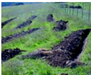
Fotografía b. Disposición de las zanjas de infiltración en el terreno
