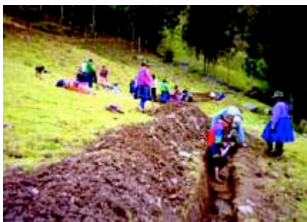
Fotografía 2. Construcción de zanjias de infiltración (Perú)
