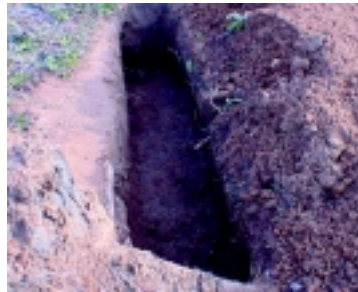
Fotografía b. Configuración de una zanja de infiltración
