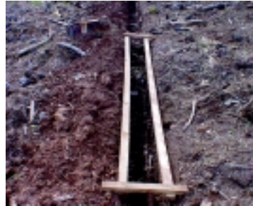
Fotografía b. Molde construcción para zanja de infiltración
