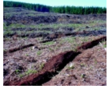
Fotografía c. Líneas de zanjas de infiltración
