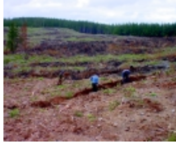
Fotografía b. Construcción de zanjas de infiltración
