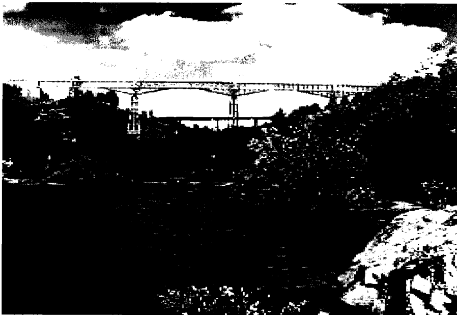
Figura N° 2. Río Malleco (viaducto), Novena Región.
