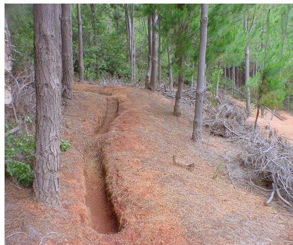
Fotografía 58. Zanjas de infiltración sedimentadas en plantación de Pino Insigne, Llongocura, VII Región
