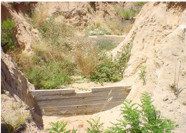
Fotografía 63. Diques de concreto. Coelemu, VIII Región
