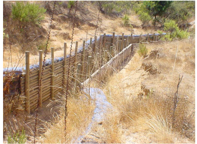
Fotografía 79. Canal recubierto con empalizada (otra vista) Alto Loica, San Pedro, Región Metropolitana
