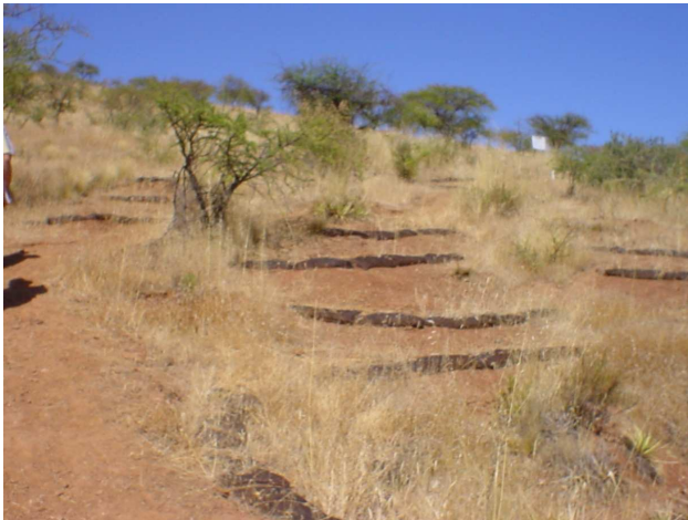
Fotografía 55. Obras lineales con bolsas de arena en módulo El Hoyo VII Región
