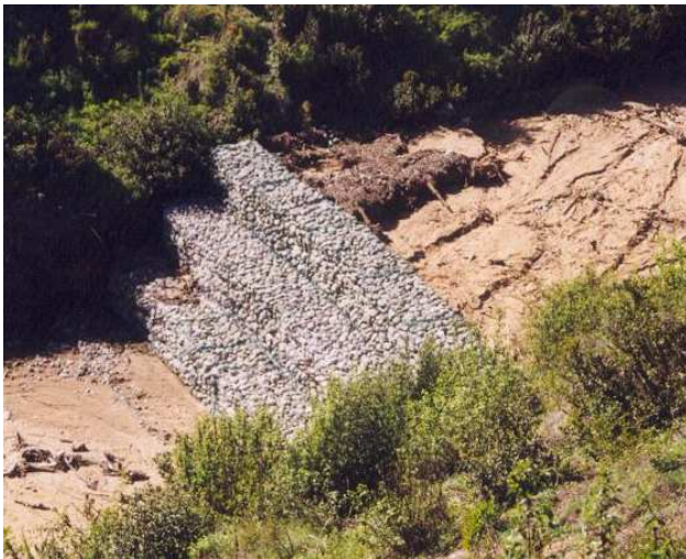
Fotografía 29. Dique de gaviones. Cuenca Las Salinas, V Región Fuente: Patricio Novoa
