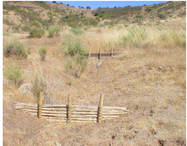
Fotografía 42. Batería de empalizadas de bambú. Proyecto Facility 1B, VI Región
