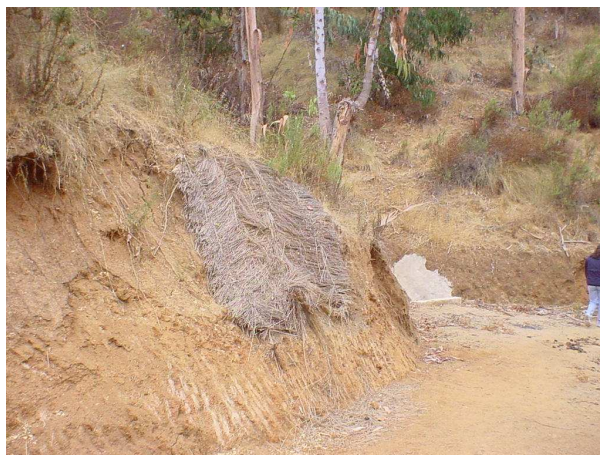
Fotografía 22. Fajina utilizada para la protección de taludes. Cerros Municipales La Ligua, V Región
