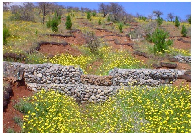
Fotografía 50. Dique de mampostería gavionada. Módulo El Hoyo, VII Región
