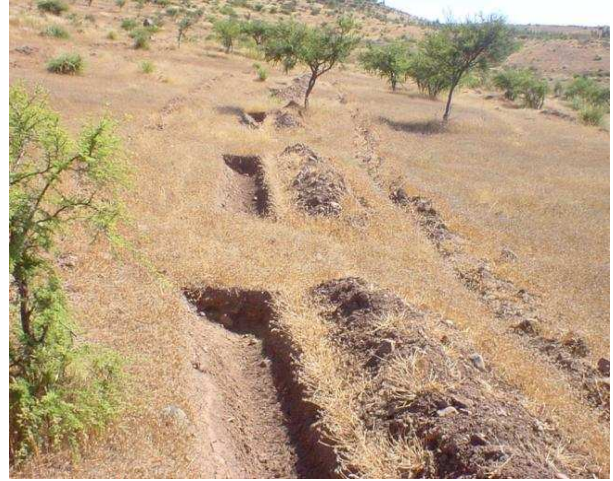
Fotografía 40. Zanjas de Infiltración Proyecto Facility 1B VI Región
