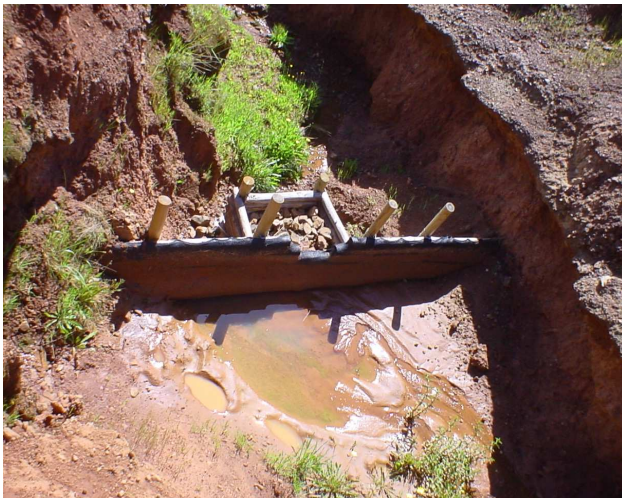
Fotografía 53. Dique de polines trabajando en módulo El Hoyo, VII Región
