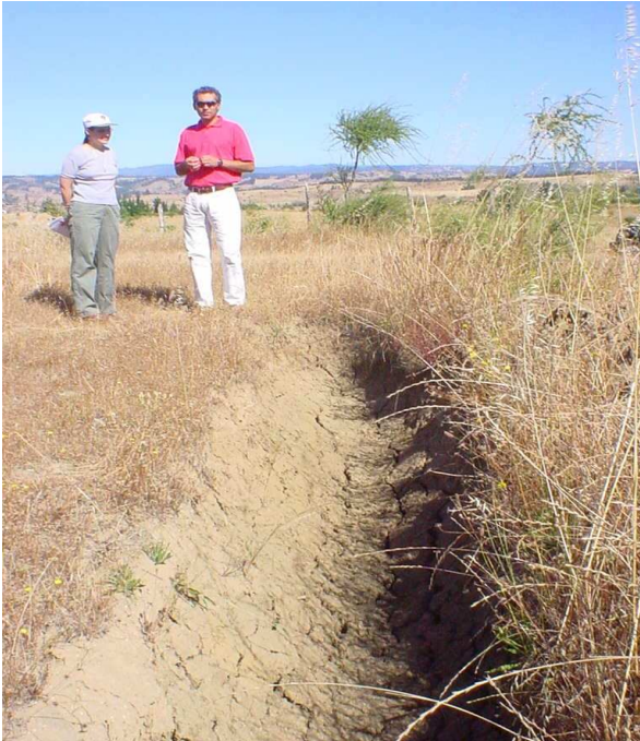
Fotografía 73. Zanjas de infiltración. Predio San José de Ninhue, VIII Región
