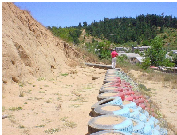
Fotografía 66. Muros de neumáticos. Coelemu, VIII Región
