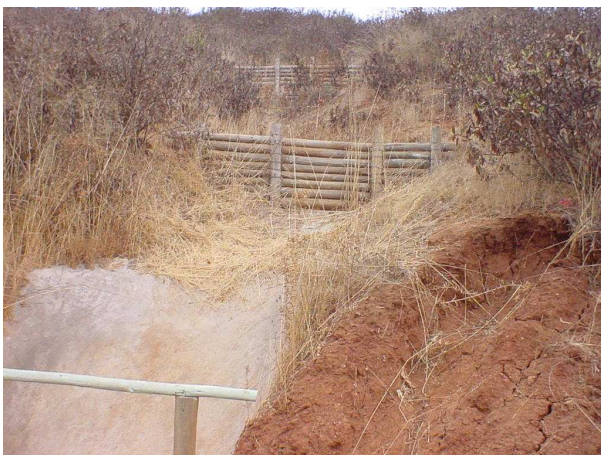
Fotografía 19. Empalizada de polines y bajada de agua revestida con cemento. Cerros Municipales La Ligua, V Región
