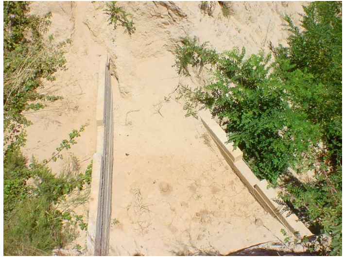
Fotografía 62. Diques de concreto colmatados. Coelemu, VIII Región
