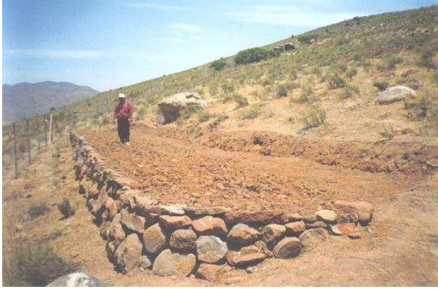
Fotografía 17. Miniterraza de piedra, Proyecto de Sabanización, Tunga Norte, IV Región Fuente: INFOR
