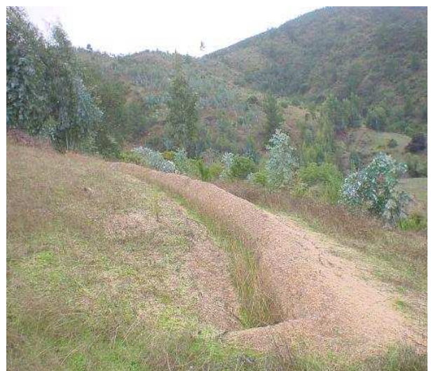
Fotografía 38. Canal de desviación construido en la cota superior del módulo hidrológico La Gloria, VI Región
