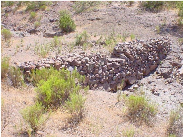
Fotografía 5. Dique de mampostería en seco. La Muñozana, IV Región
