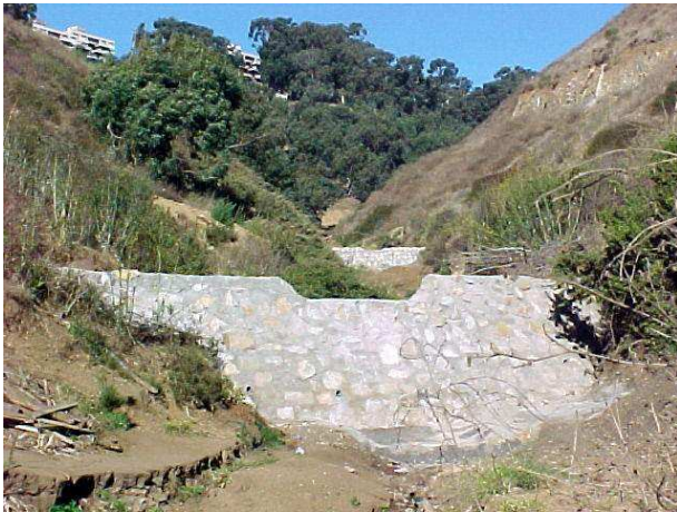
Fotografía 31. Diques de mampostería hidráulica en microcuenca Los Lúcumos, V Región Fuente: Patricio Novoa
