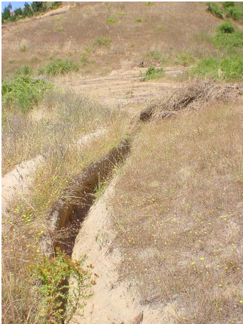
Fotografía 61. Zanjas de infiltración. Coelemu, VIII Región
