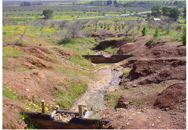
Fotografía 52. Batería de diques de polines en módulo El Hoyo, VII Región
