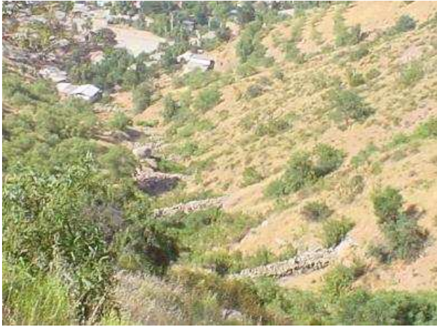
Fotografía 13. Batería de diques de mampostería en seco. Cerro Pajaritos, IV Región
