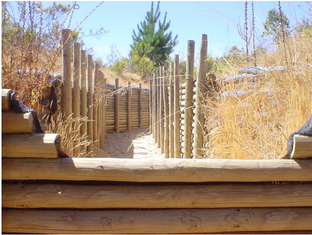
Fotografía 78. Canal recubierto con empalizada Alto Loica, San Pedro, Región Metropolitana
