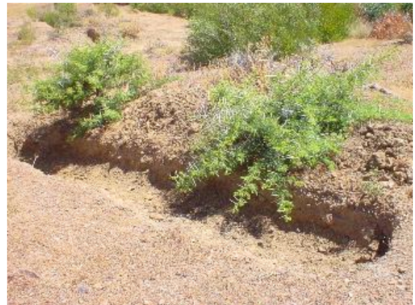
Fotografía 4. Zanja de infiltración con plantación de Prosopis chilensis . El Sauce, IV Región
