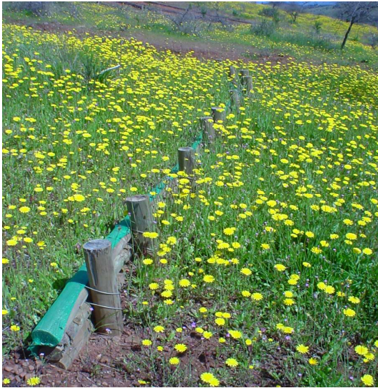
Fotografía 51. Empalizada con polines impregnados en módulo El Hoyo, VII Región
