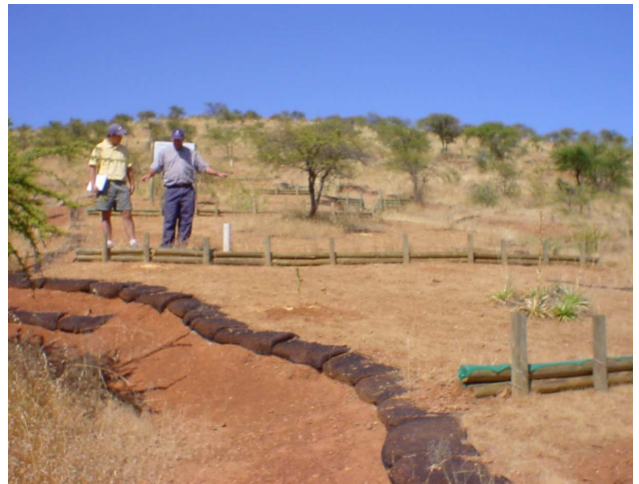
Fotografía 54. Tratamiento lineal con bolsas de arena en módulo El Hoyo, VII Región
