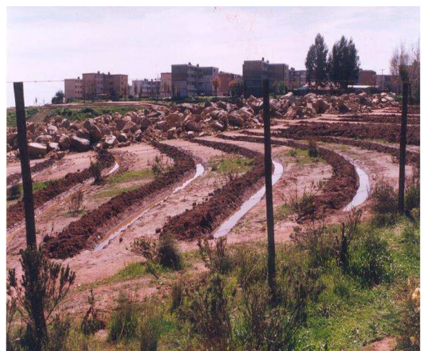
Fotografía 30. Surcos de Infiltración Cuenca Las Salinas, V Región Fuente: Patricio Novoa
