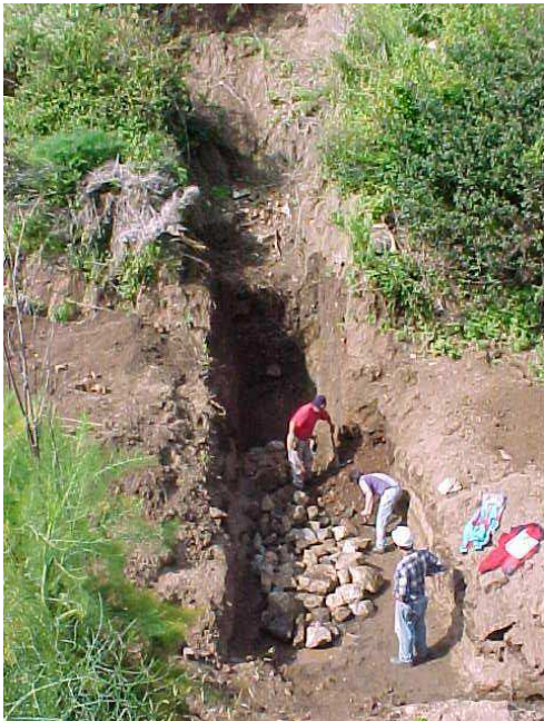
Fotografía 33. Herido para diques de mampostería hidráulica en microcuenca Los Lúcumos, V Región Fuente: Patricio Novoa
