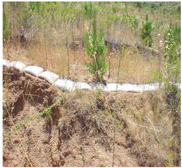
Fotografía 72. Obras lineales con bolsas de tierra Predio Santa Sofia, VIII Región
