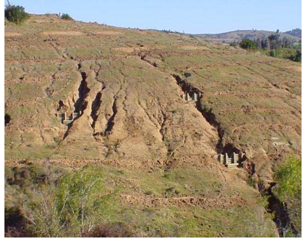
Fotografía 44. Batería de diques de polines Lagunillas, VI Región
