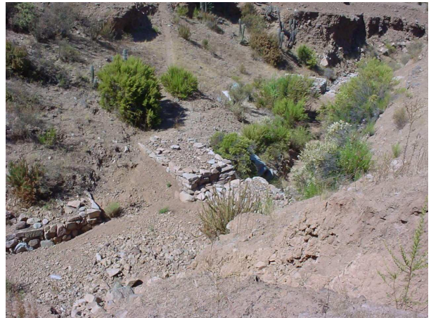
Fotografía 26. Batería de diques de mampostería en seco, Quebradas La Parra y Nazareto, Petorca V Región
