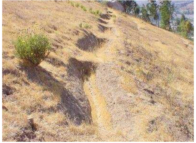
Fotografía 14. Zanjas de infiltración. Cerro Pajaritos, IV Región
