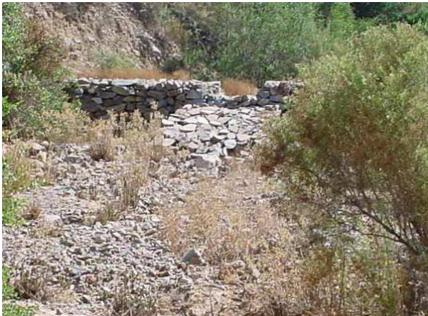
Fotografía 25. Dique de Mampostería en seco Quebradas La Parra y Nazareto, V Región
