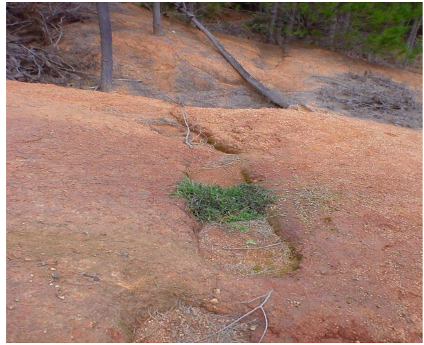
Fotografía 60. Zanjas de infiltración colmatadas Llongocura, VII Región
