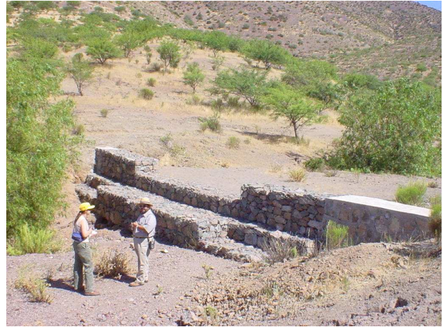
Fotografía 6. Dique de mampostería gavionada con empotramiento de mampostería hidráulica La Muñozana, IV Región
