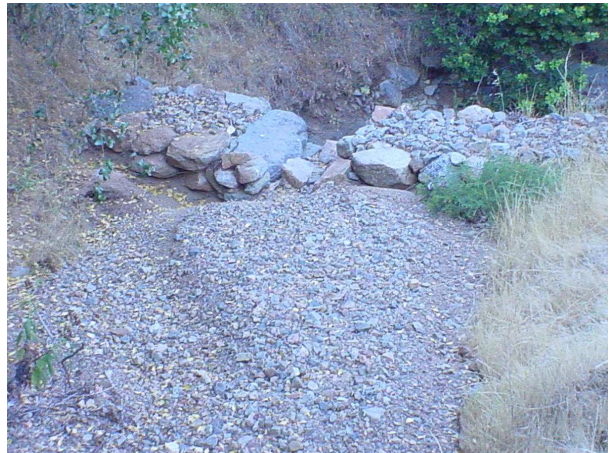
Fotografía 12. Dique de mampostería en seco colmatado. Cuesta Cavilolén, IV Región
