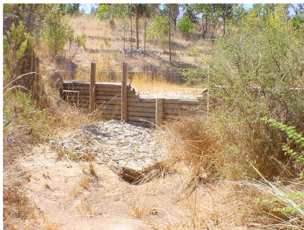
Fotografía 77. Dique de polines impregnados y dissipador de energía de piedras. Alto Loica, San Pedro, Región Metropolitana
