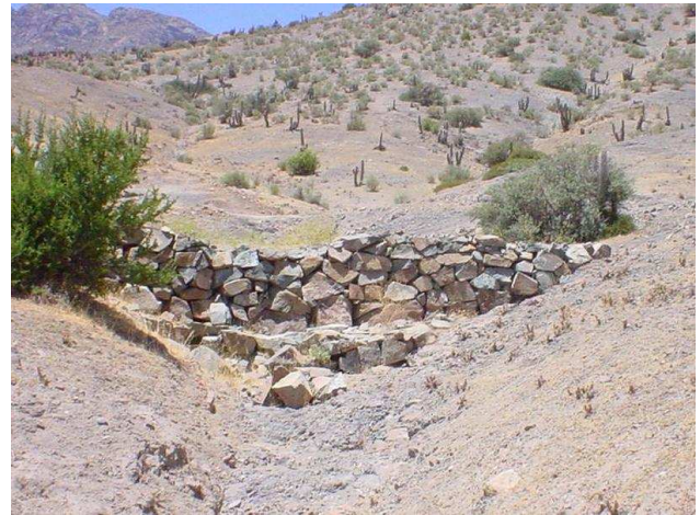
Fotografía 8. Dique de mampostería en seco Cuenca Monte Patria, IV Región
