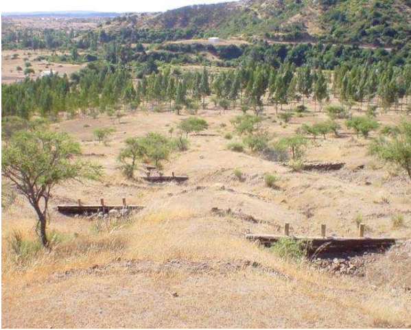
Fotografía 39. Batería de empalizadas Proyecto Facility 1B, VI Región
