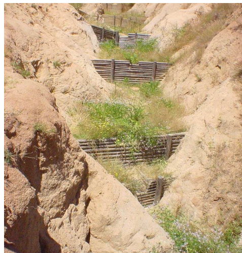
Fotografía 64. Batería de diques de polines. Coelemu, VIII Región
