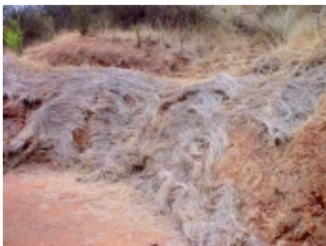
Fotografía 11. Fajinas utilizadas para protección de talud, La Ligua, V Región
