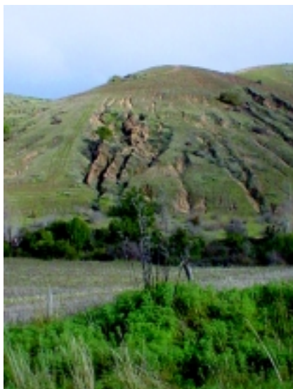
Fotografía 5. Erosión en cárcavas, Manzanares, VIII Región
