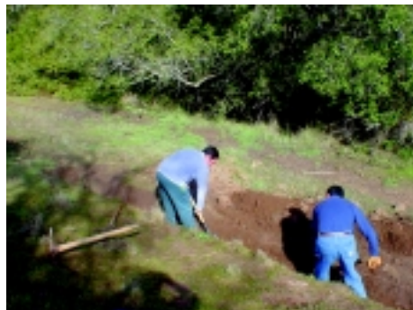
Fotografía 34. Construcción del canal de evacuación, Paredones, VI Región
