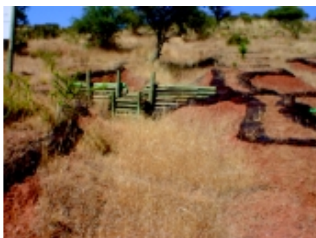
Fotografía 21. Diques de polines y tratamiento con sacos, módulo el Hoyo, VII Región
