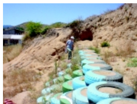
Fotografía 26. Muros de neumáticos, Coelemu, VIII Región
