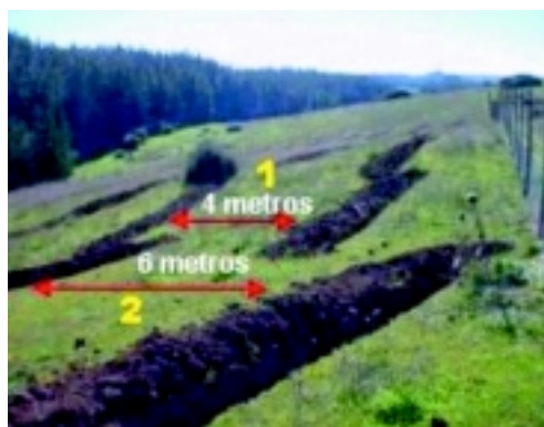
Fotografía 45. Distanciamiento de zanja según diseño
