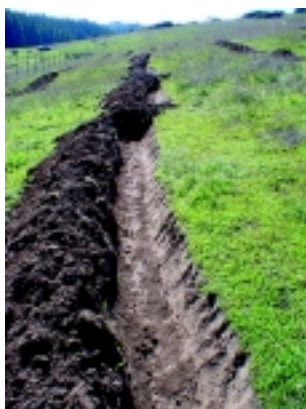
Fotografía 31. Zanja de infiltración con corte biselado y camellón, Hidango, VI Región
