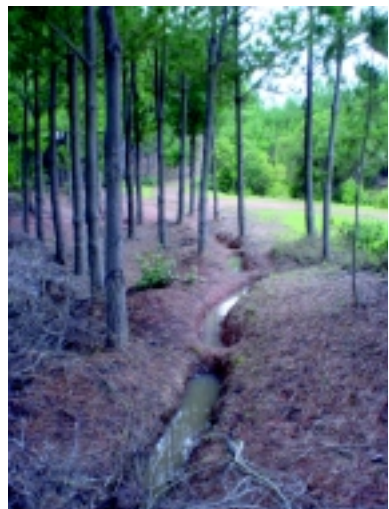
Fotografía 57. Zanjas trabajando sector Llongocura, VII Región
