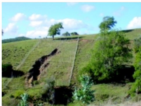
Fotografía 39. Vista general del ensayo Paredones
