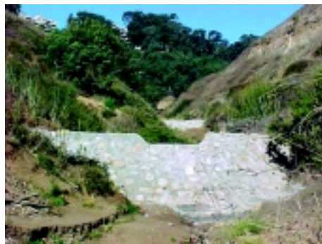
Fotografía 14. Dique de mampostería hidráulica, microcuenca Los Lúcumos, V Región
