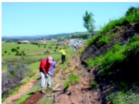
Fotografía 29. Construcción de zanja de infiltración en curva de nivel, Paredones, VI Región
