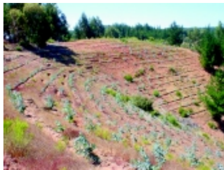
Fotografía 16. Vista panorámica de microterrazas con zanjas de infiltración, Paredones, VI Región
