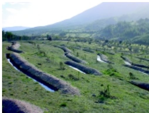
Fotografía 52. Zanjas trabajando, sector Name, VII Región
