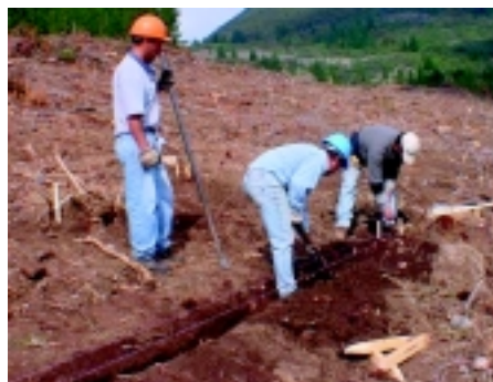
Fotografía 30. Construcción de zanja de infiltración, Llohué, VIII Región
