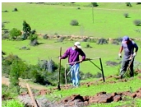
Fotografía 27. Nivelación con caballete para el trazado de zanjas de infiltración, Paredones, VI Región
