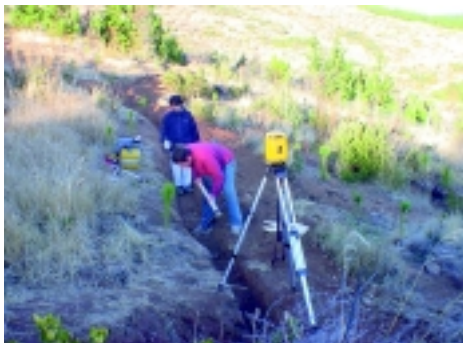
Fotografía 33. Nivel de ingeniero y construcción del canal de evacuación, Llanillos, VII Región
