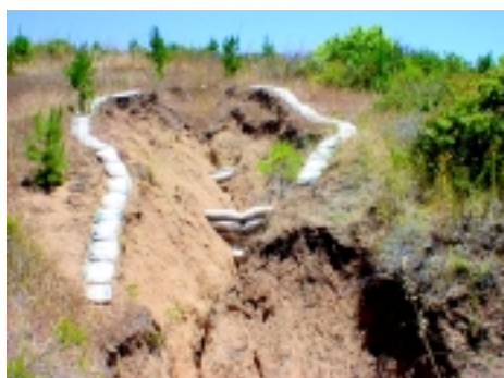
Fotografía 25. Vista general una cárcava con diques y obras lineales de sacos, predio Santa Sofía, VIII Región
