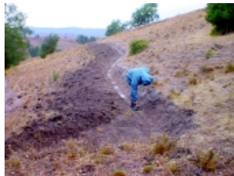
Fotografía 36. Verificación del diseño del canal, Paredones, VI Región
