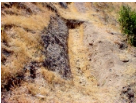
Fotografía 7. Zanja de infiltración, Cerro Pajaritos, IV Región
