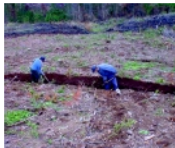
Fotografía 5. Actividades de mantención de las obras
