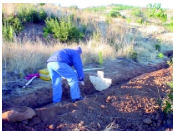
Fotografía 18. Molde de construcción de canales
