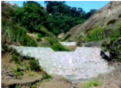
Fotografía 22. Diques de mampostería hidráulica (V Región)
