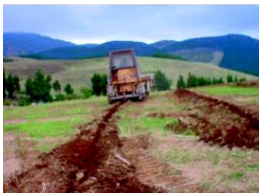
Fotografía 43. Faena de subsolado a 5 metros de espaciamiento entre líneas. (Manzanares, VIII Región)
