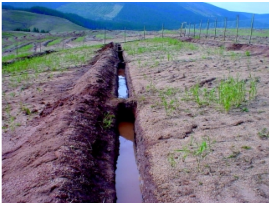
Fotografía 14. Funcionamiento de las zanjas de infiltración después de la caída de lluvias en Manzanares, VIII Región
