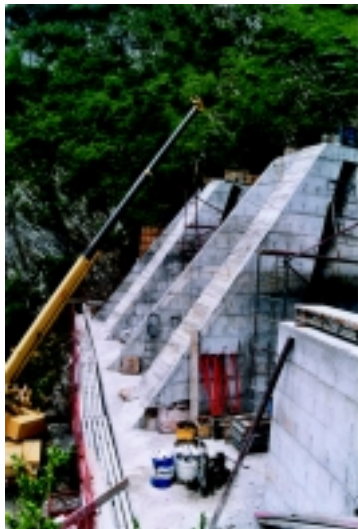
Fotografía 32. Construcción de diques (Paramento inclinado aguas abajo)
