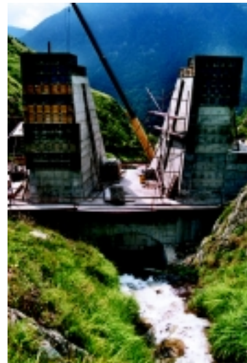
Fotografía 33. Construcción de diques (Paramento inclinado aguas arriba)
