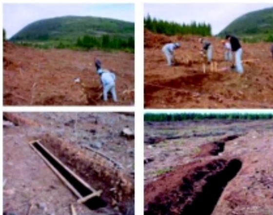
Fotografía 7. Faenas de construcción de zanjas de infiltración
