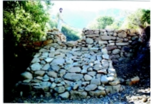
Fotografía 21. Dique de mampostería en seco (V Región)
