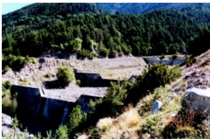
Fotografía 30. Disposición de diques consecutivos para el control de torrentes
