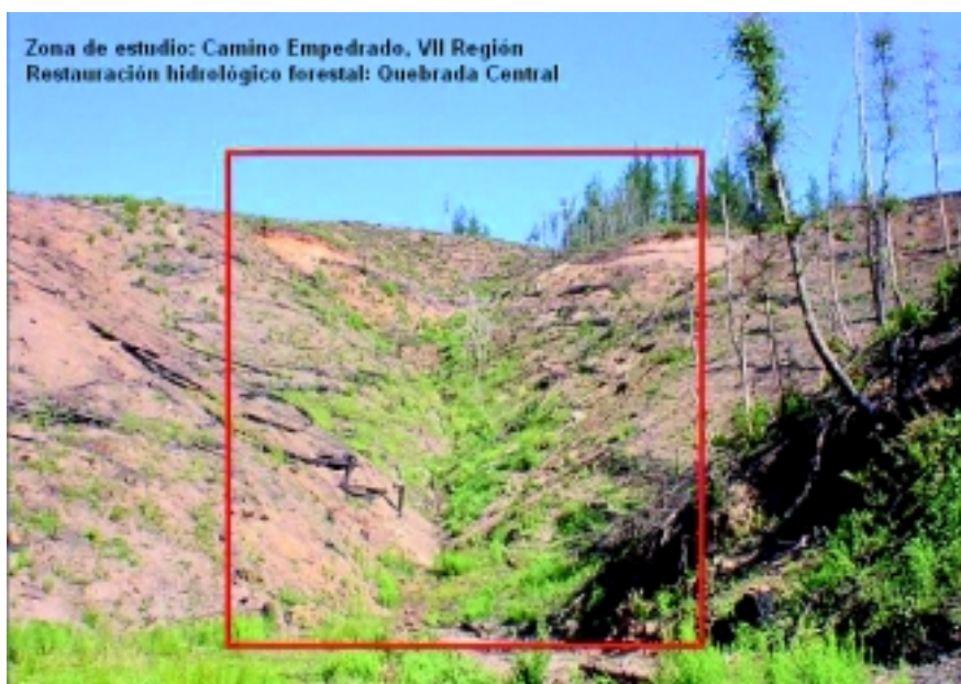
Fotografía 29. Ubicación de un dique (mampostería hidráulica) en una quebrada
