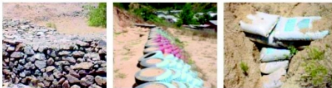
Fotografía 38. Muretes de contención de sedimentos (murete de piedras, IV Región; murete con neumáticos, VIII Región; murete de sacos, VIII Región)
