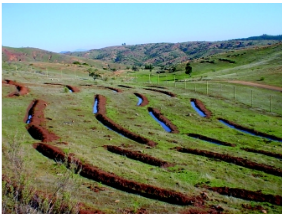
Fotografía 12. Funcionamiento de las zanjas de infiltración después de la caída de lluvias en Pumanque, VI Región
