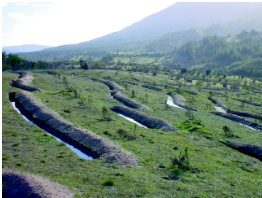
Fotografía 13. Funcionamiento de las zanjas de infiltración después de la caída de lluvias en Name, VII Región
