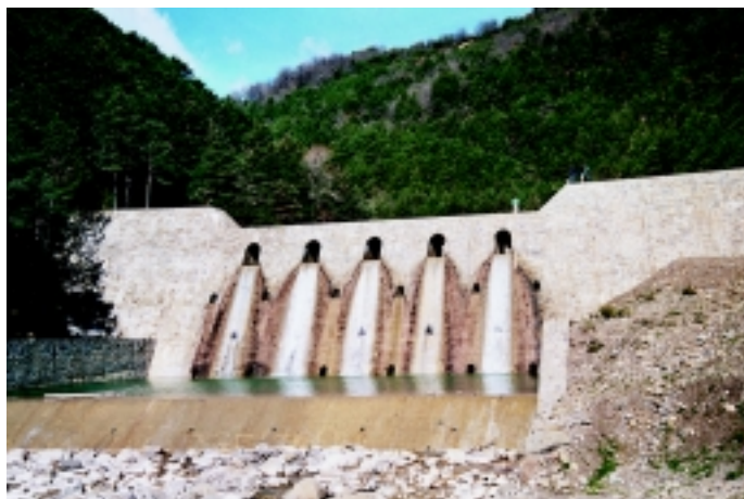
Fotografía 34. Diques con mechinales
