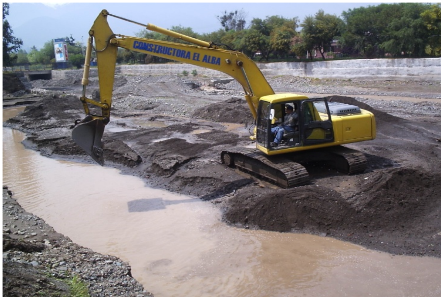
TRABAJO DE LIMPIEZA CON MAQUINARIA
