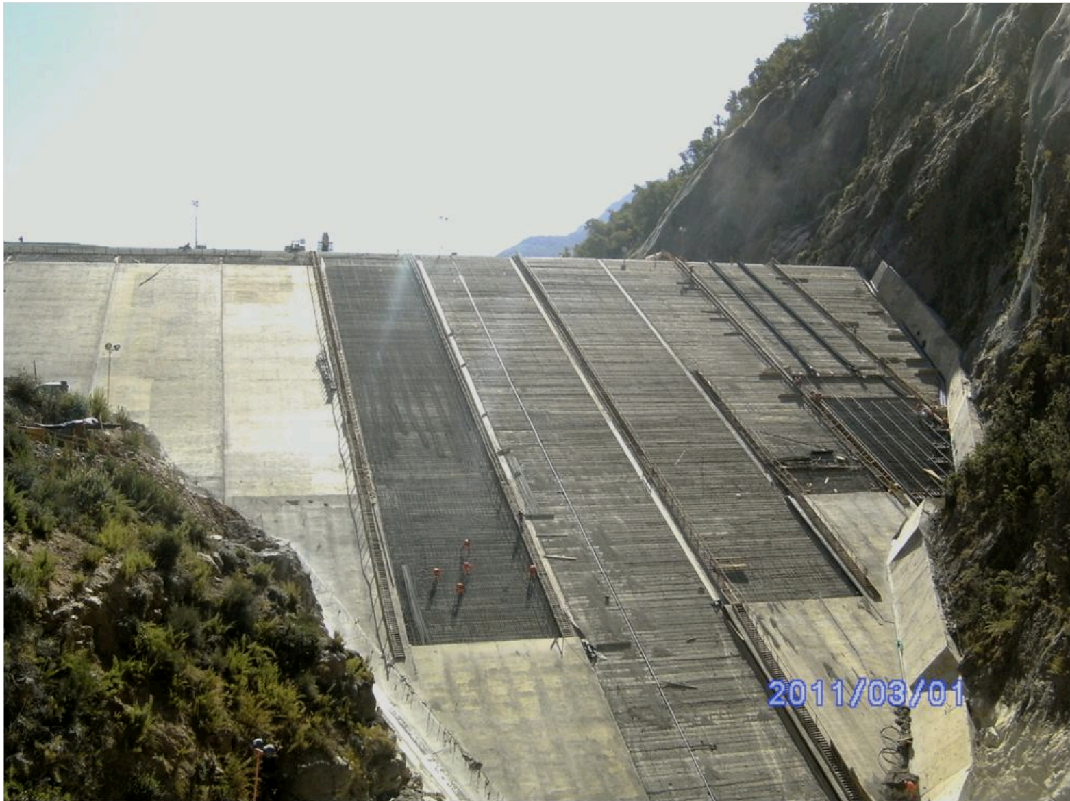
Embalse Ancoa, Región del Maule vista frontal de la pantalla del muro
