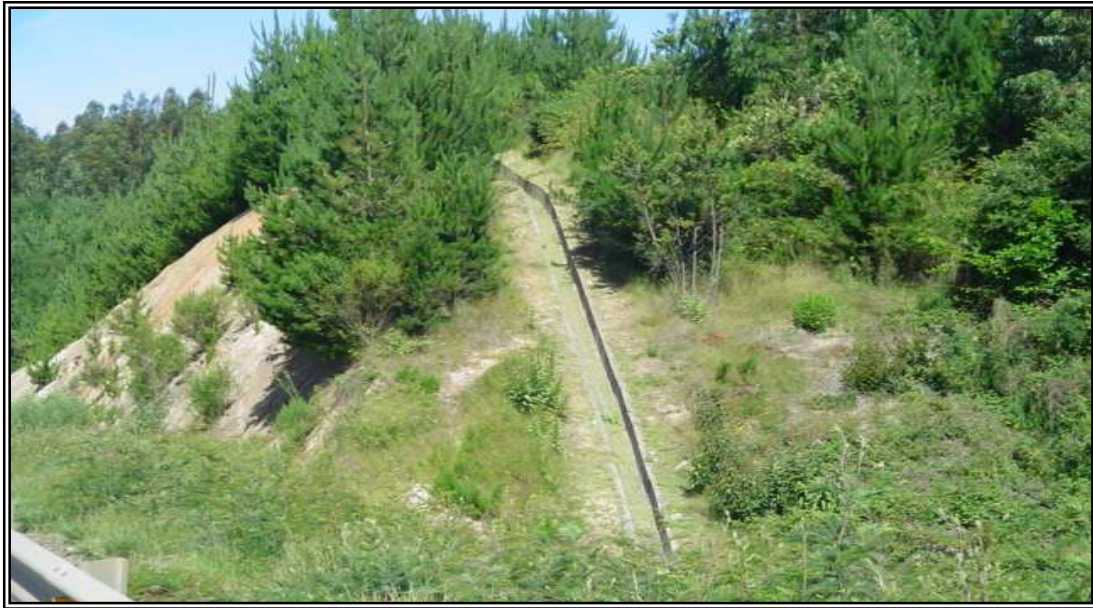
Figura nº 32: Canal de evacuación de aguas.
