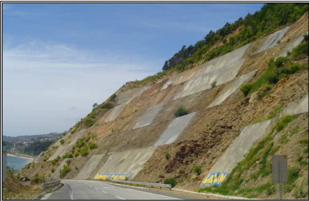
Figura nº 31: Obras de mampostería en ladera de ubicada en la carretera Itata.
