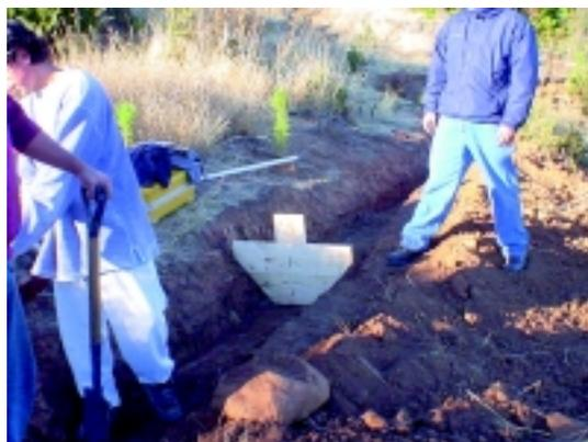
**Fotografía 16.** Uso de molde para la construcción del canal de desviación en Llanillos (VII Región)
