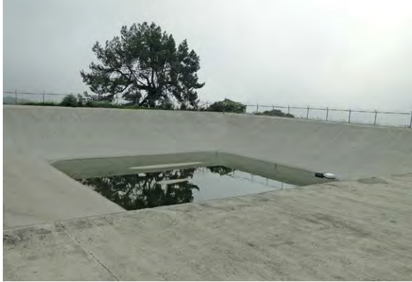
Figura 5. Captación de aguas lluvias u olla comunitaria en el municipio de Tlalnepantla, Estado de Morelos, México.
