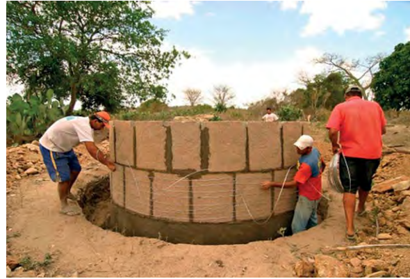
Figura 6. Construcción de Cisterna, Hormigón prefabricado, México. Fuente: Unesco 2015.
