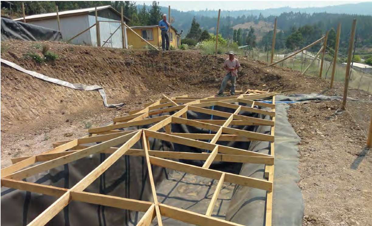
Figura 9. Excavación revestida con geomembrana, con capacidad de 50 m 3 en el sector de El Huapi, Licantén, Región del Maule.
