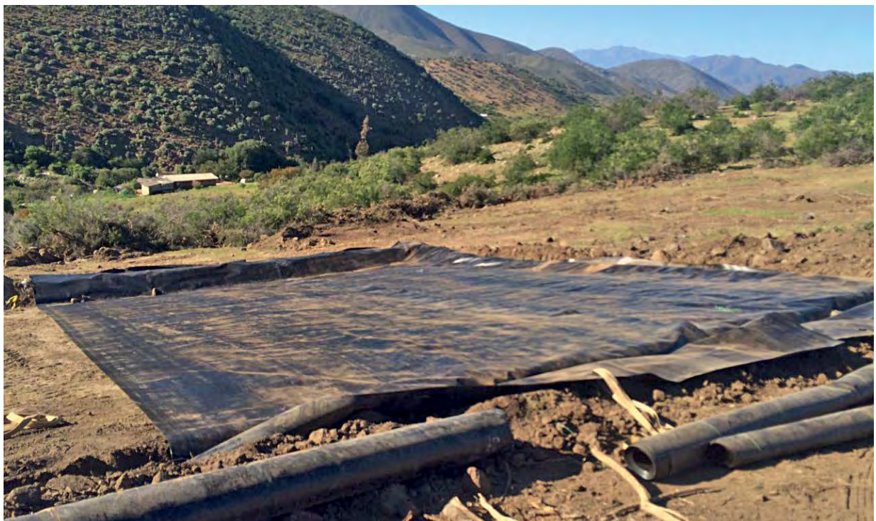
Figura 29. Despliegue de geomembrana sobre el área de captación en Las Palmas.
