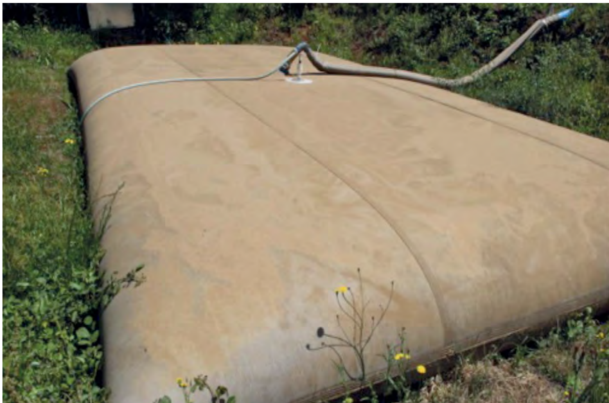
Figura 14. Tanque flexible con capacidad de 30 m 3 en el sector Loma de Vásquez, Longaví, Región del Maule.
