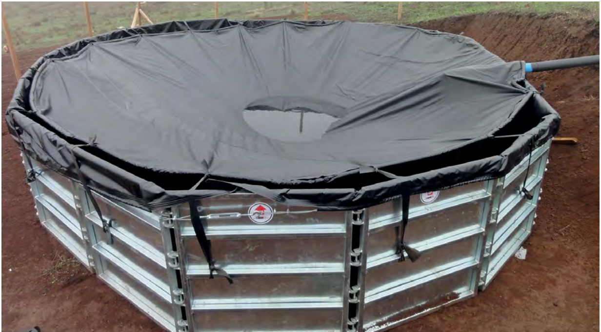
Figura 11. Estanque australiano con capacidad de 40 m 3 en el sector de Peño Alto, Pelluhue, Región del Maule.
