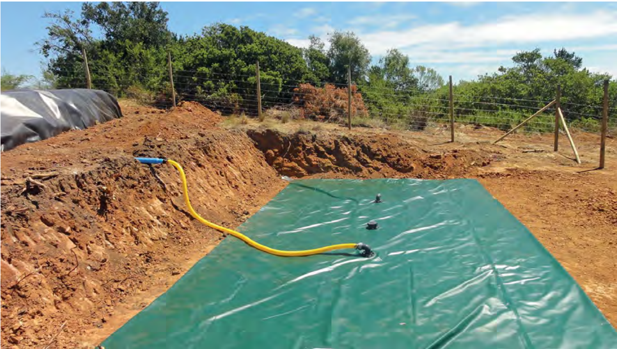
Figura 31. Instalación de hidroacumulador en RN Lago Peñuelas.
