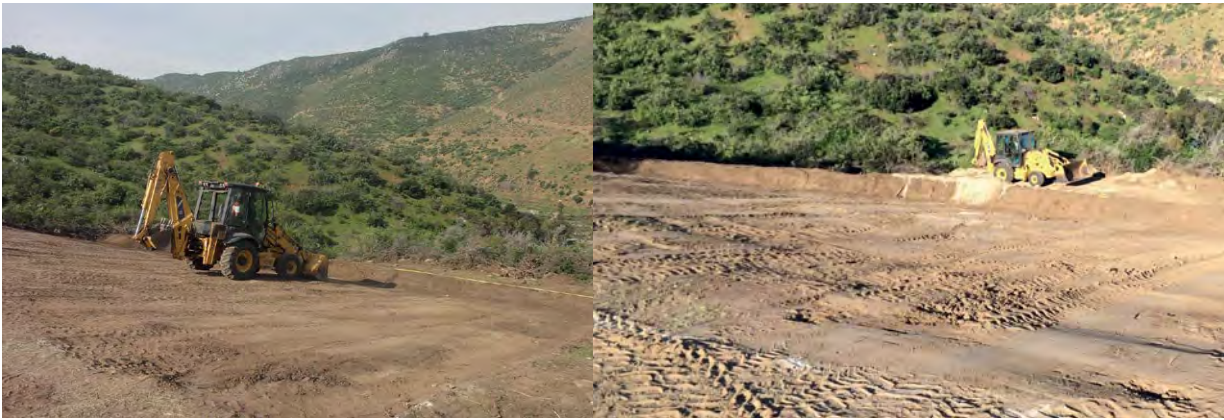
Figura 25. Remoción de tierra y aplanamiento del sitio en Las Palmas.
