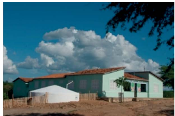
Figura 4. Programa P1MC, Cisternas de acumulación de aguas lluvias en Escuelas, Brasil. Fuente: Pizarro et al. 2016.
