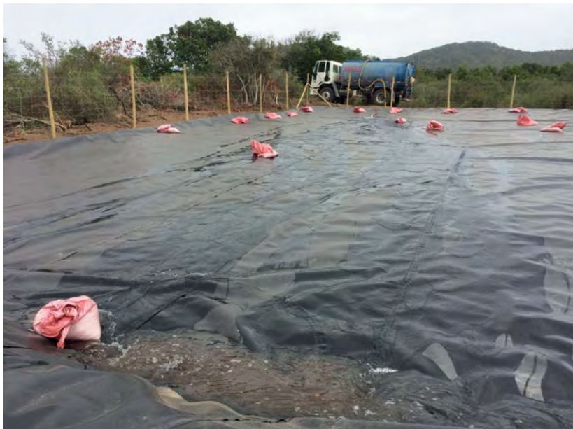
Figura 35. Camión aljibe depositando agua sobre la geomembrana en zona de captación de Las Palmas.
