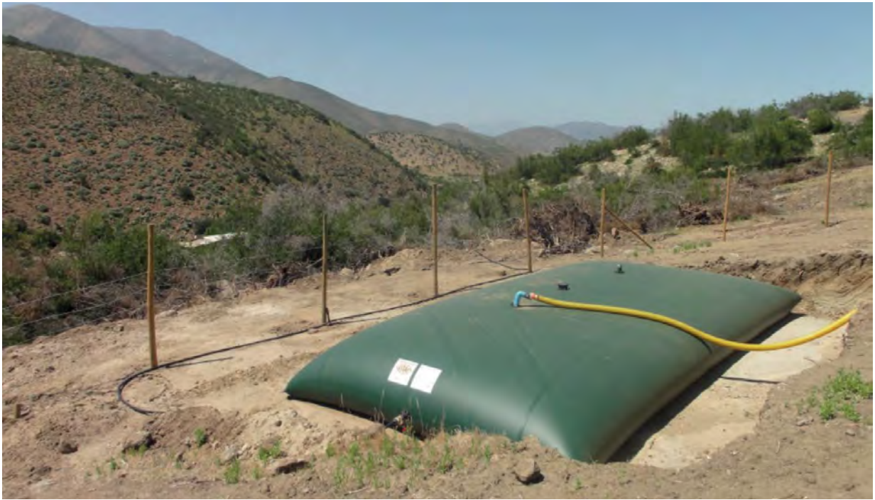
Figura 22. Hidroacumulador en estanque flexible de 30 m 3 ubicado en Las Palmas.
