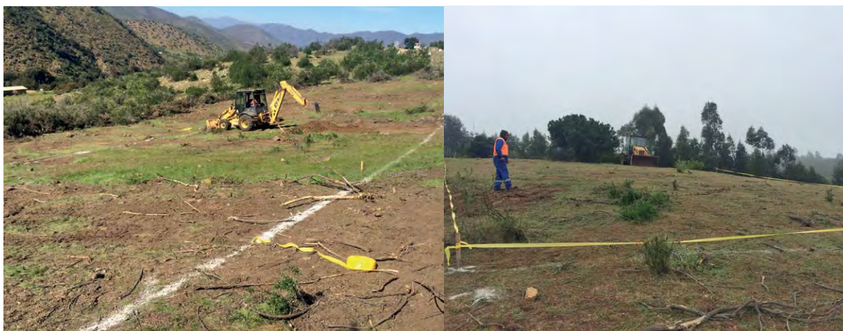
Figura 24. Demarcación y limpieza del sitio de emplazamiento del SCALL en el sector de Las Palmas.
