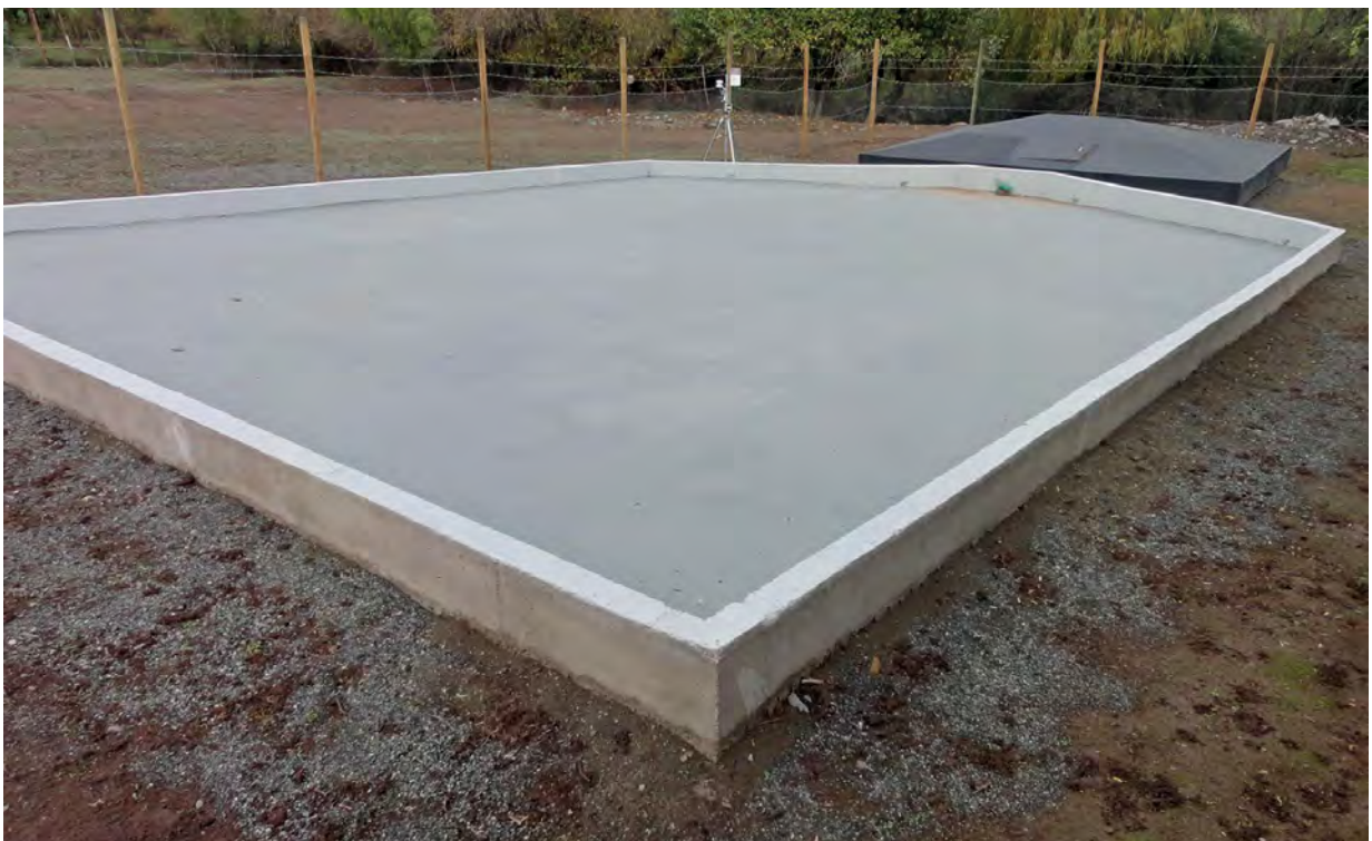
Figura 8. Área de captación de hormigón en el sector de Los Marcos, Longaví, Región del Maule.
