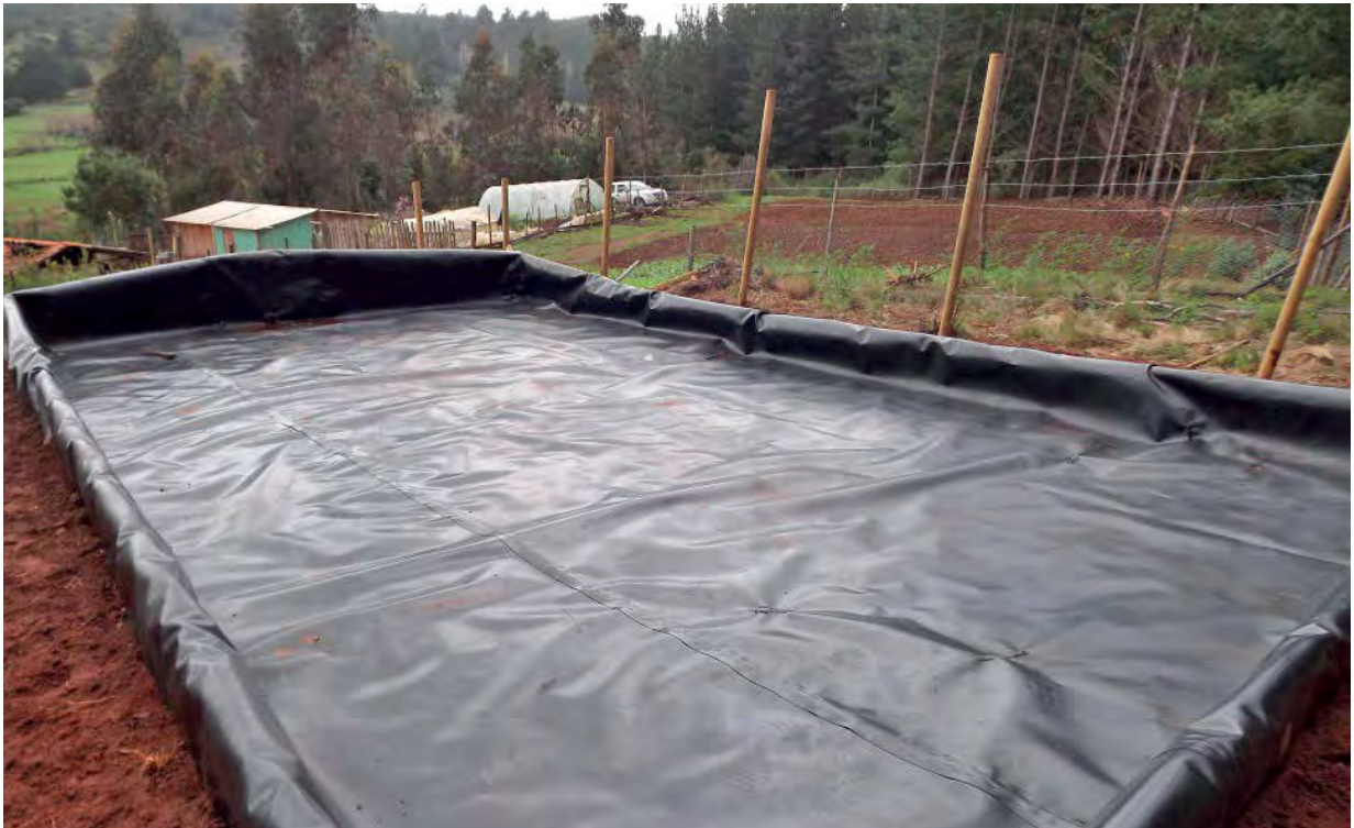
Figura 7. Área de captación de geomembrana en el sector de Peralillo, Chanco, Región del Maule.
