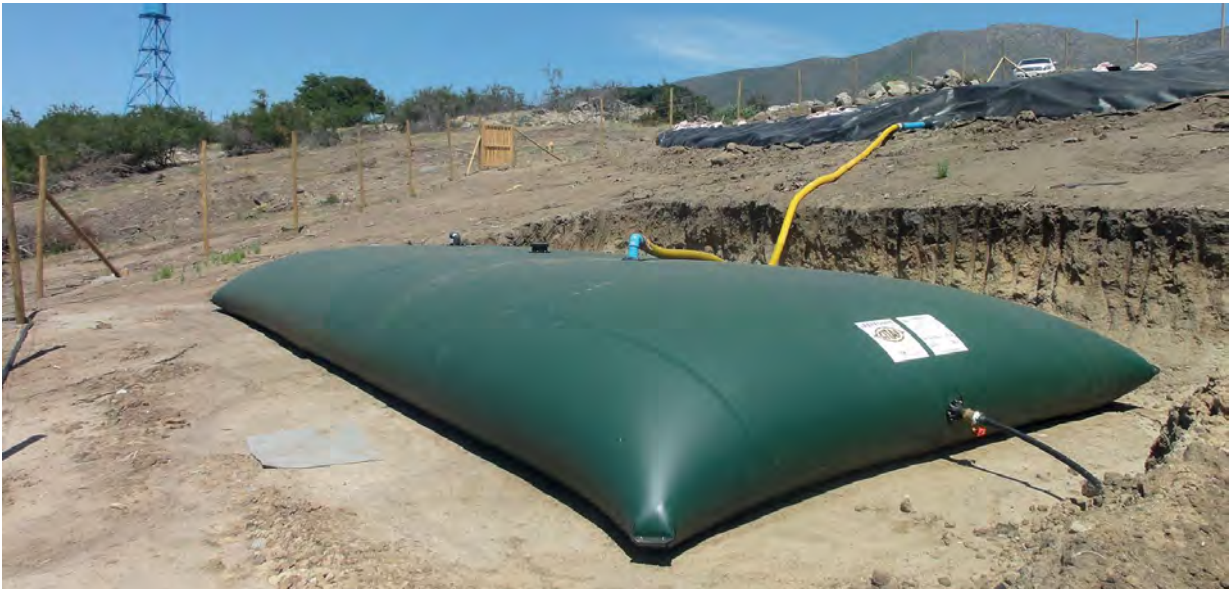
Figura 34. Vista del hidroacumulador en Las Palmas con el sistema conectado para la entrada de agua lluvia captada y su salida hacia el sistema de riego.
