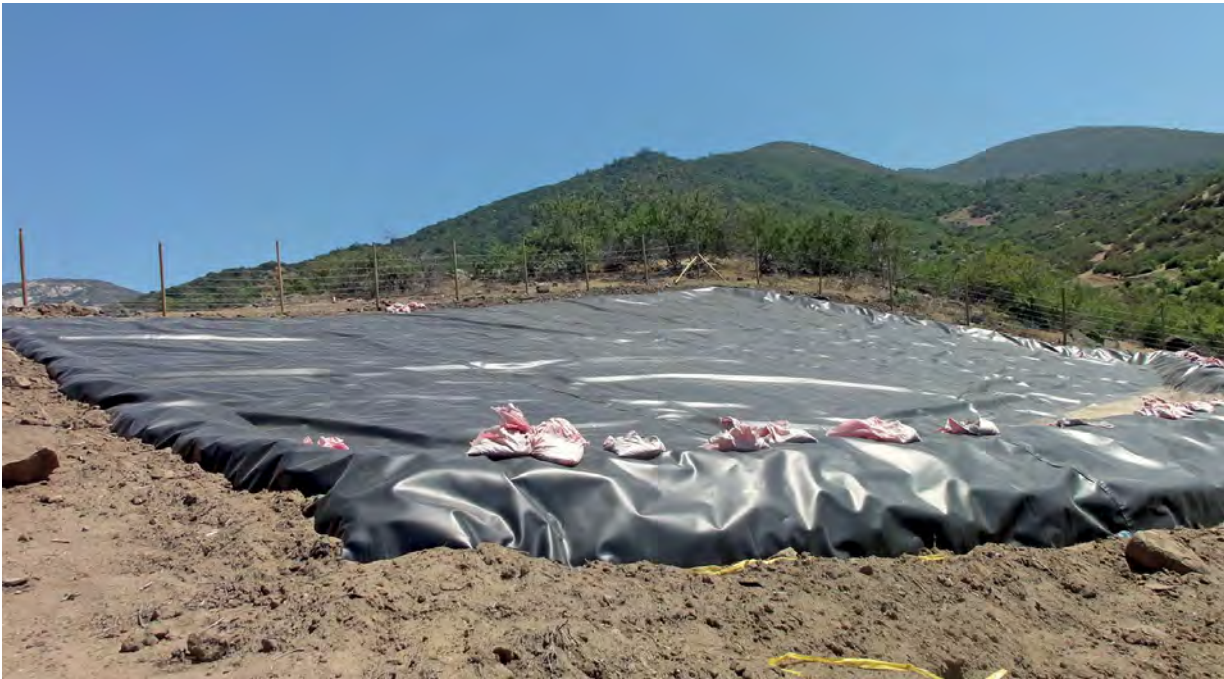
Figura 30. Geomembrana enterradas en las canaletas en Las Palmas.
