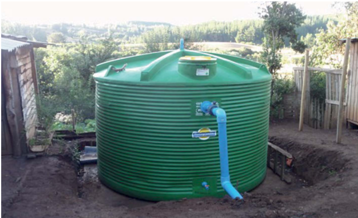
Figura 13. Estanque de PVC con capacidad de 20 m 3 en el sector Peralillo, Chanco, Región del Maule.
