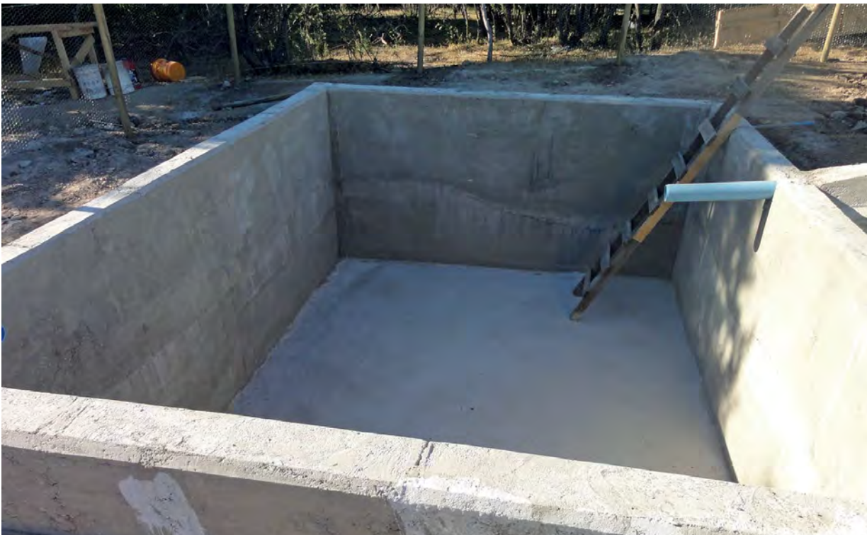
Figura 10. Excavación revestida con hormigón, con capacidad de 30 m 3 en el sector de Los Marcos, Longaví, Región del Maule.
